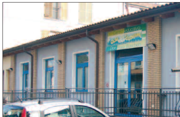
Il centro educativo nella sede centrale di via Lomonaco
